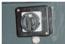
Главный выключатель, фиксирующийся замком
